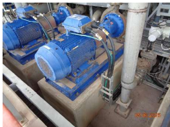
ภาพที่ 2.2-10 ฐานรองรับคอนกรีตเสริมเหล็ก ป้องกันการสั่นสะเทือน
