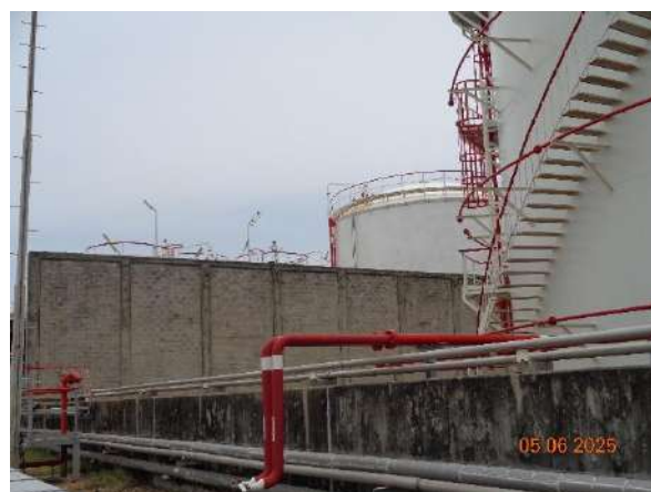
ภาพที่ 2.2-31 Bund Wall ของแต่ละกลุ่มถัง
