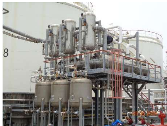
ภาพที่ 2.2-8 Vent Condensing Unit
