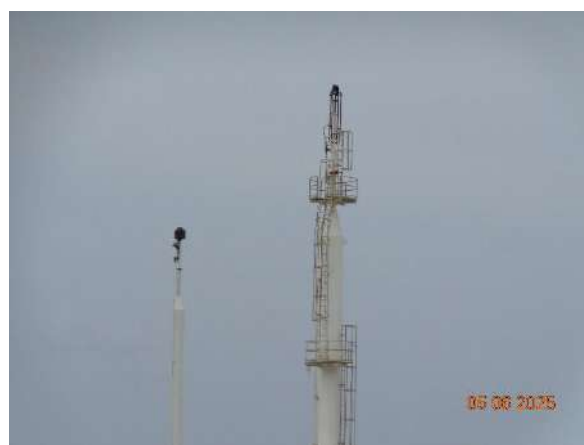
ภาพที่ 2.2-4 หอเผาทิ้งเหนือระดับพื้นดิน (Elevated Flare)
