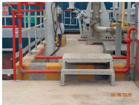
ภาพที่ 2.2-18 คันคอนกรีตล้อมรอบทำเทียบเรือ
