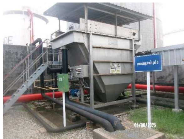
ภาพที่ 2.2-14 Oil-Water Separator
