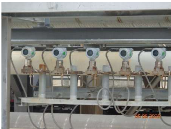
ภาพที่ 2.2-7 Pressure Transmitter
